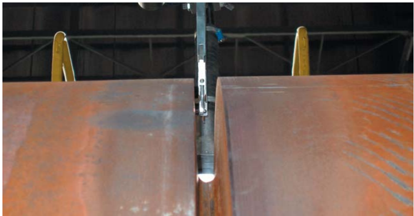
Rys.2. Widok rowka przy spawaniu wąskoszczelinowym.
